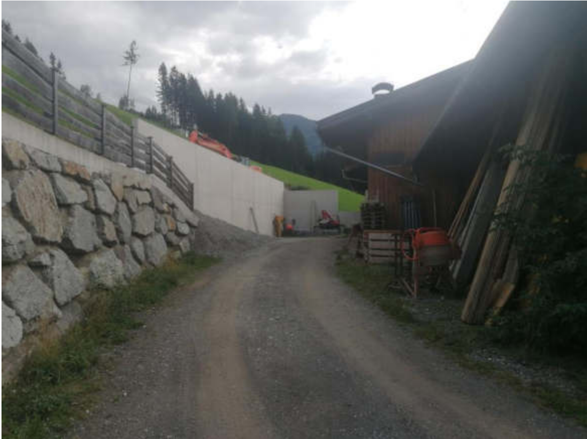
Abb. 2: Standort der geplanten Lagerhalle hangseitig der Hofstelle; Foto Planalp
